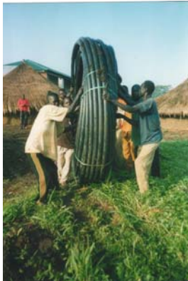
Figura 3 Sistemazione dei tubi per la rete idrica
