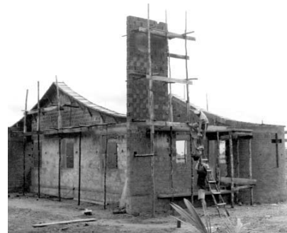
Figura 6 I danni del nubifragio all'esterno della chiesa
