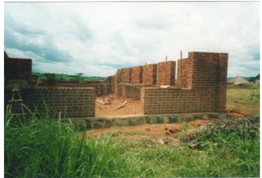
Figura 2 Dispensario in costruzione
