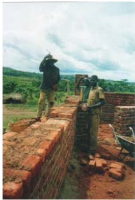
Figura 1 Costruzione del Dispensario
